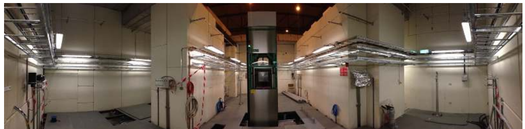
(b) Vue panoramique de l'intérieur du bunker, (vue face au faisceau Upstream ).
